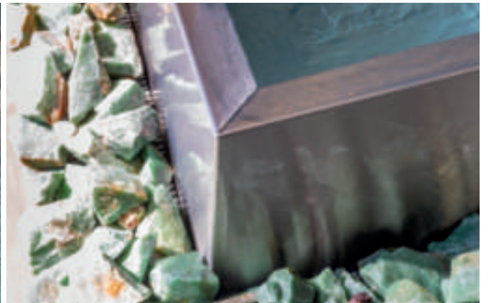
Auf eineinhalb Seiten zur Terrasse hin wurde eine freie Überlaufkante geschaffen. Das Wasser läuft 40 cm tief in die Rinne, die dekorativ mit Steinen belegt ist.
