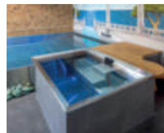
Der Whirlpool ist direkt an den Beckenkörper des Edelstahlpools angeschweißt. Beide Becken sind über einen Kreislauf miteinander verbunden.
