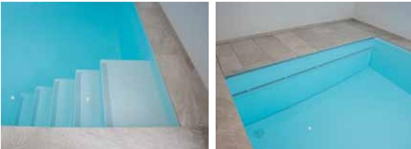
**Eine bequeme Einstiegstreppe führt hinein ins Schwimmbecken. Der Unterflurrollladen ist platzsparend unter dem High Level-Schacht positioniert. Dank der High Level-Technik verfügt das Becken über einen sehr hohen Wasserspiegel.**
