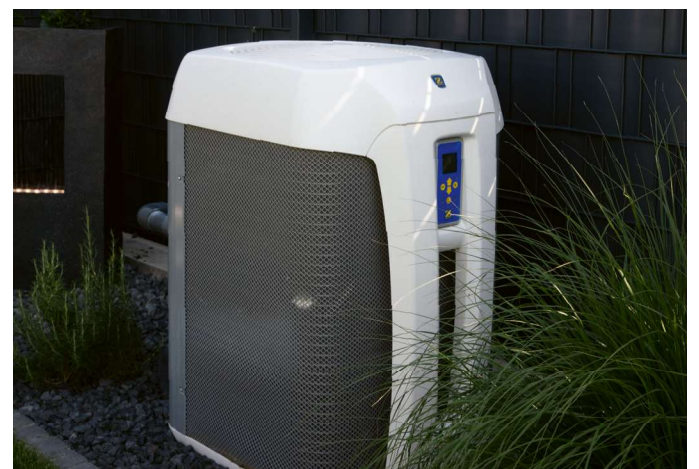
Beheizt wird das Becken von einer Zodiac-Wärmepumpe ZS 500.
