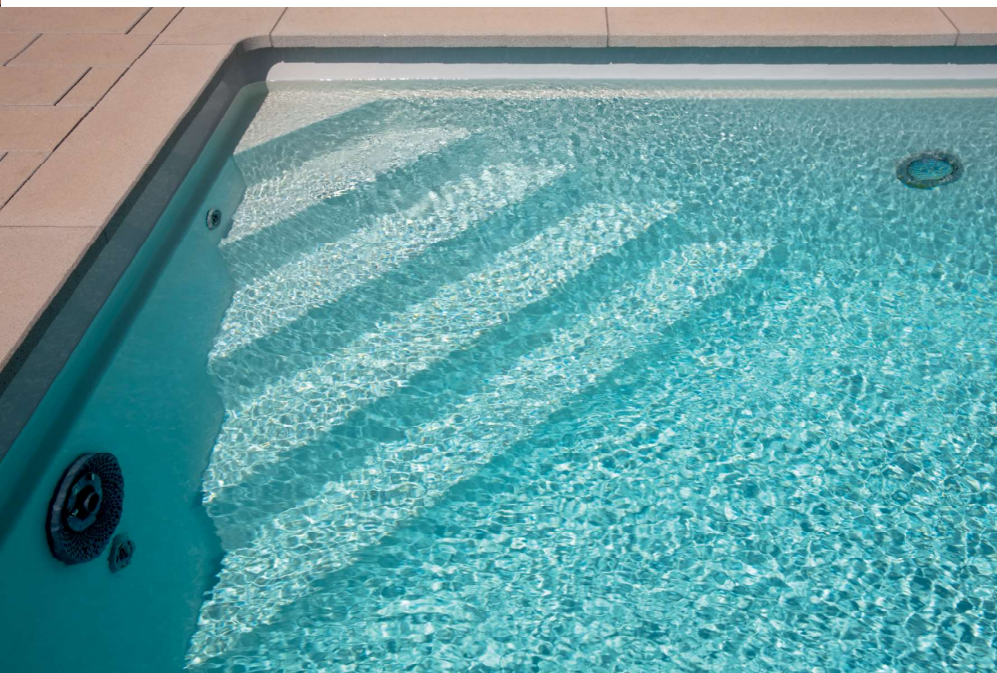
Das Skimmerbecken mit Einstiegstreppe über Eck, einer sopra Gegenstromanlage und zwei Unterwasserscheinwerfern.
