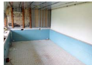
Bilder oben Zuvor war das in die Jahre gekommene Becken breiter und nicht mehr zeitgemäß isoliert.
